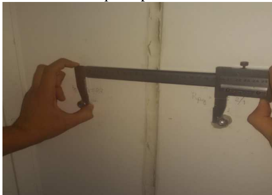
Рисунок 1 – Вимірювання розходження деформаційного шва
